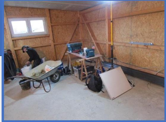
Da unsere Arbeitskapazitäten für die Trockenbau-Arbeiten mit Wand- und Deckendämmung und Verkleidung mit OSB-Platten in Folge der genannten Schwächungen überfordert waren, wurde die Firma Treutwein im November dazu beauftragt.
