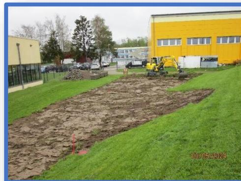
Die Wiesenfläche zwischen Erdwall und Simm Bad mussten wir nach umfangreichen Kabelgrabenarbeiten für die neue Stromversorgung rekultivieren und neu begrünen. Die Planungen für Elektro und den übrigen Innenausbau wurden in einigen Baubesprechungen vorangetrieben. Die Böschungsmauer zum Erdwall haben wir erhöhen müssen und mit Rollkies fachgerecht hinterfüllt.
